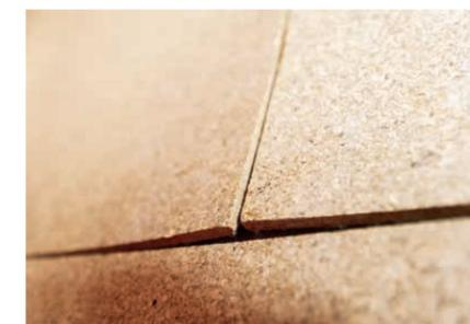
Auf manchen Booten sind zur Isolierung der Wände Korkplatten verklebt. Die lösen sich teils
